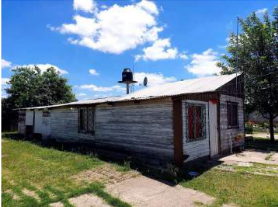
Casilla de madera y chapa, Villa Brown
