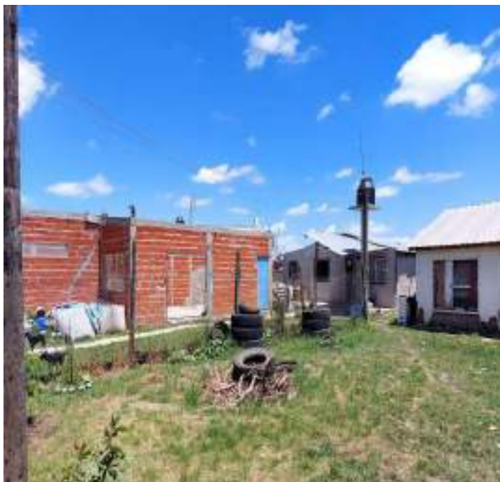
Construcción Barrio Villa Brown
