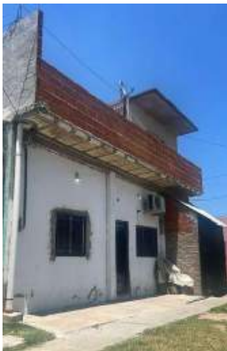
Construcción barrio Santo Domingo
